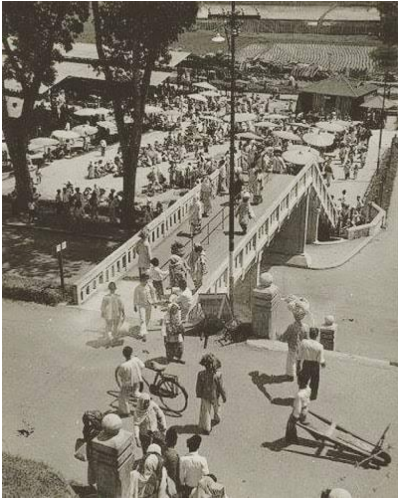
Janjang Gantuang Bukittinggi tahun 1940-1960
